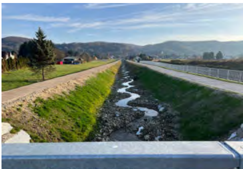
zweiter HW Bauabschnitt von ÖBB Brücke bis Lehnnergasse
