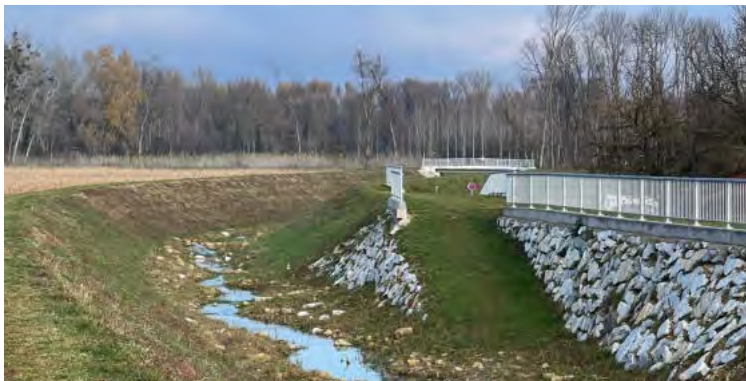
erster HW Bauabschnitt Au bis ÖBB Brücke
