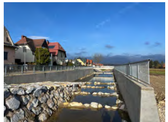
neues, zweites Geschiebefangbecken
